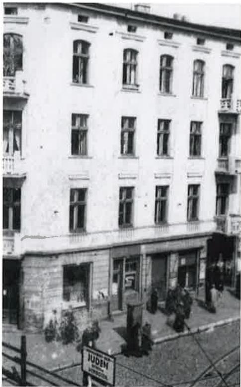
Das Gebäude des Archivs, o. J. Archive building, n.d. © APL, PSZ, Sign. 1125
